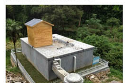
温州瓯海区农村污水处理工程
