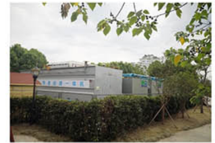
德清县云岫路建昌桥雨水排放口截污治理工程
