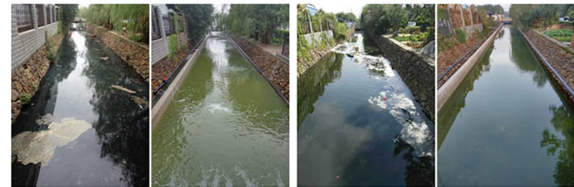
毕家支河剿灭劣V类项目 施工两周后水质对比
