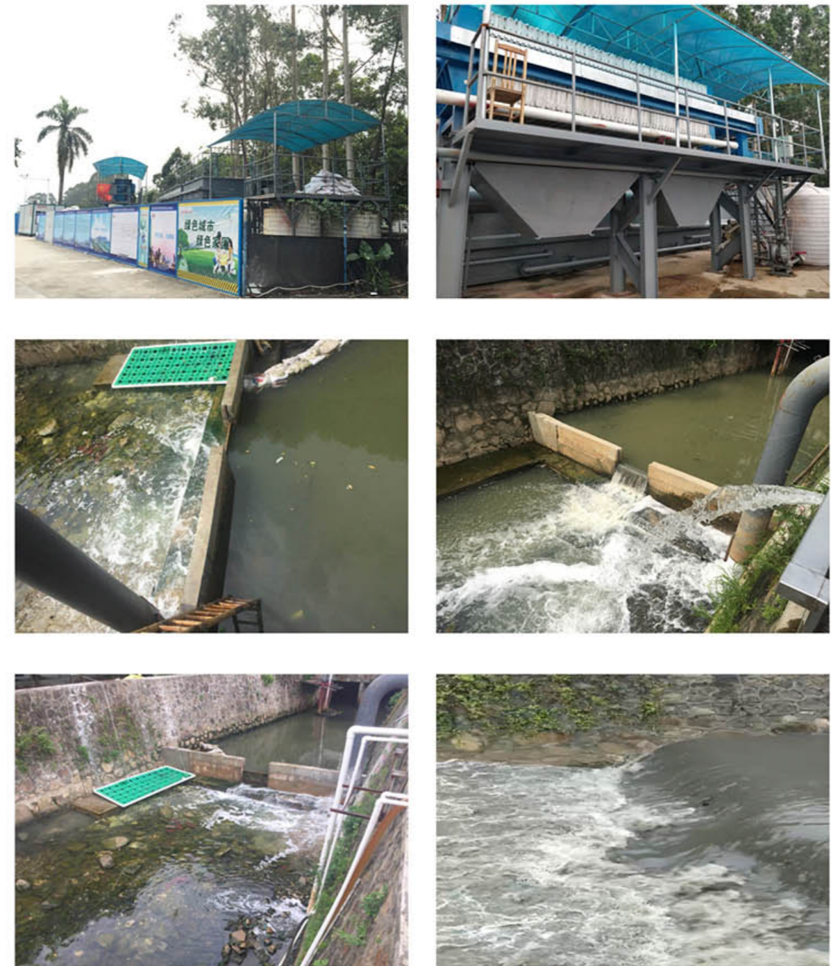
支流拦水坝，雨天大水量溢流，晴天污水收集处理排放
