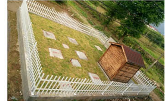
东阳湖溪镇前山村生活污水治理工程
