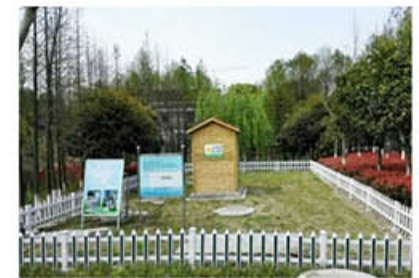
余杭星桥农村生活污水处理工程
