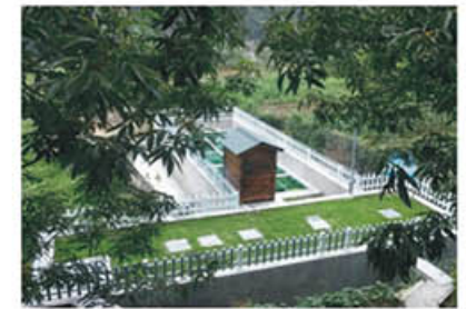
临安市清凉峰镇小石门村生活污水处理工程
