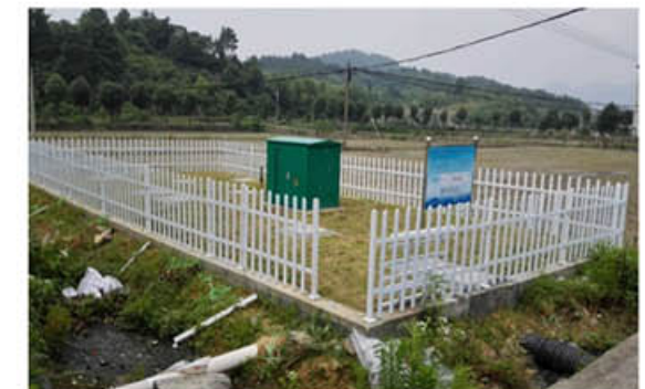
东阳湖溪镇金宅村生活污水治理工程
