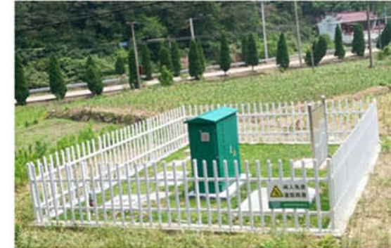
东阳湖溪镇塘北村生活污水治理工程
