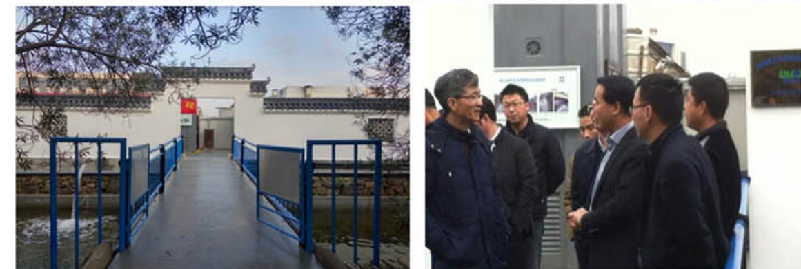
舟山毕家支河黑臭综合治理工程
