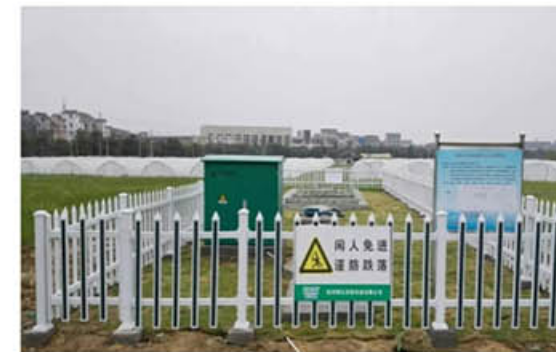
东阳六石街道矩路村生活污水治理工程
