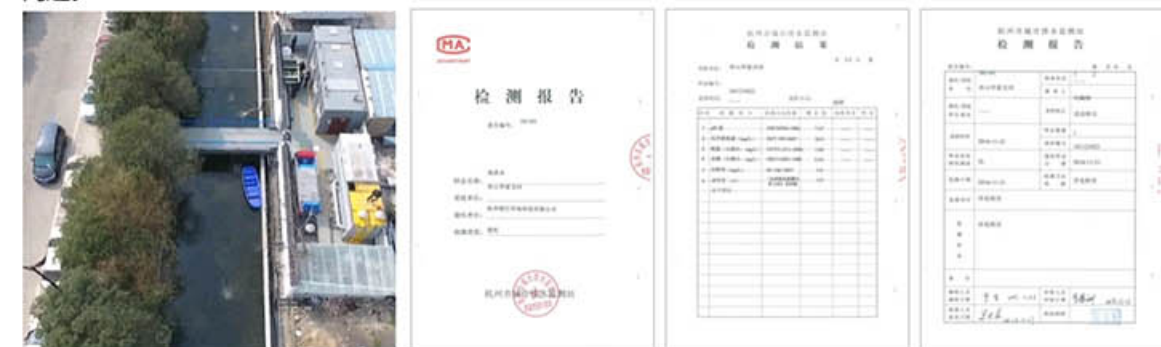
舟山毕家支河黑臭综合治理工程航拍图
