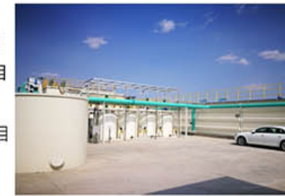
南京市江宁区泵站前池污水处理项目
